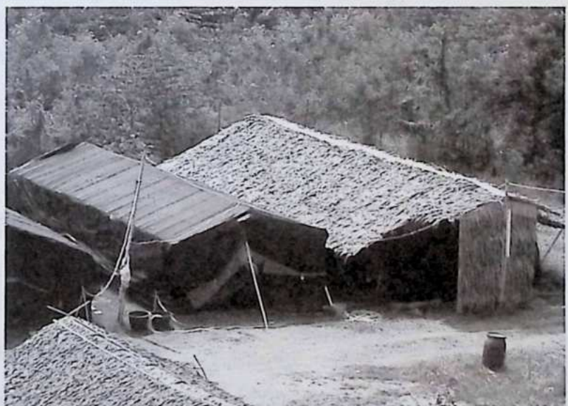
โรงเพาะเห็ดทั้งกลุ่มร้อนชื้นและเย็นชื้นตั้งอยู่ใกล้กัน
